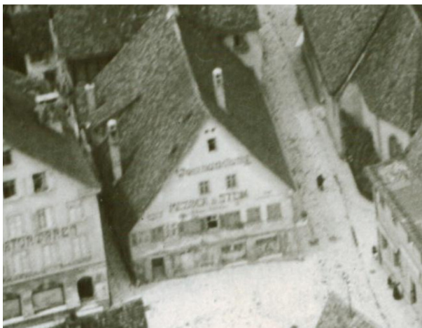
Wohn- und Geschäftshaus David Steins, Kapellengasse 6
