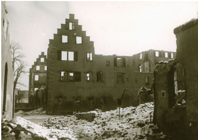
Abb. 4: Blick auf das zerstörte Schloss
