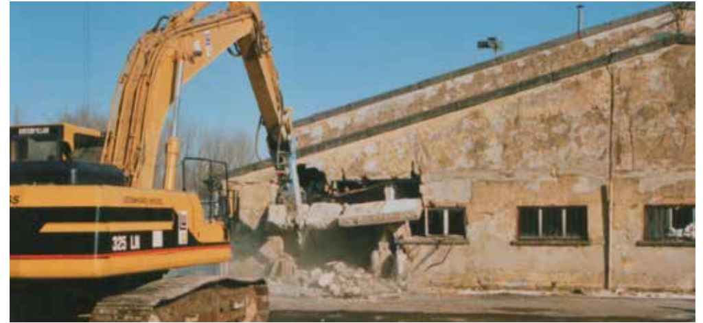
OFFIZIELLER BEGINN DER ABBRUCHARBEITEN, 27. JANUAR 2000
